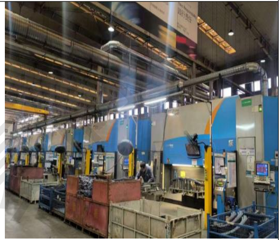
新增弧焊废气+激光切割废气收集装置
